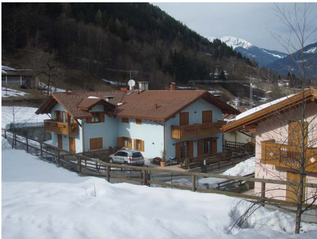
Vista delle coperture delle p.ed. 647 e 654 a cui dovranno far riferimento le nuove edificazioni dei lotti B2 e B3
