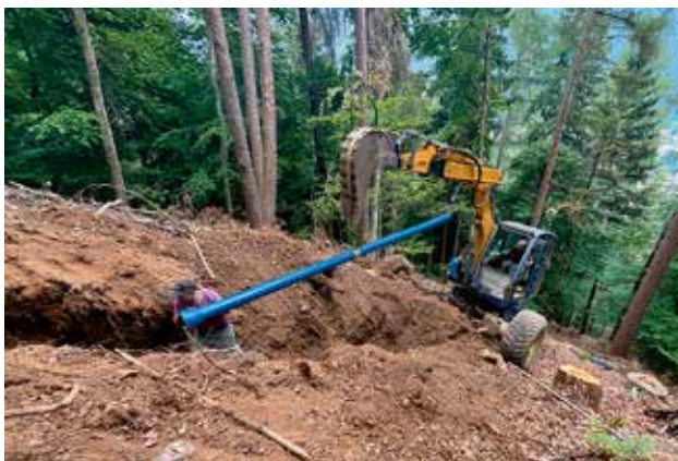
Lavori di sostituzione condotta acquedotto - tratto da Vastone a Strembo
