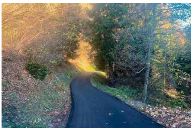
Lavori di asfaltatura strada Pler
