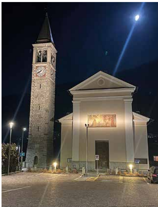
Nuova illuminazione della chiesa e del campanile
