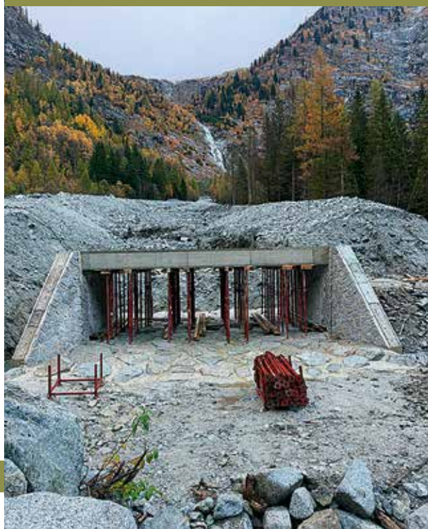
Lavori di Somma Urgenza in Val Genova
