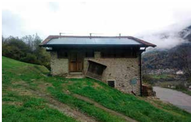
Nuovo impianto fotovoltaico Casa Dos
