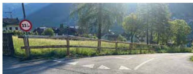
Nuove recinzioni in località Gròli
